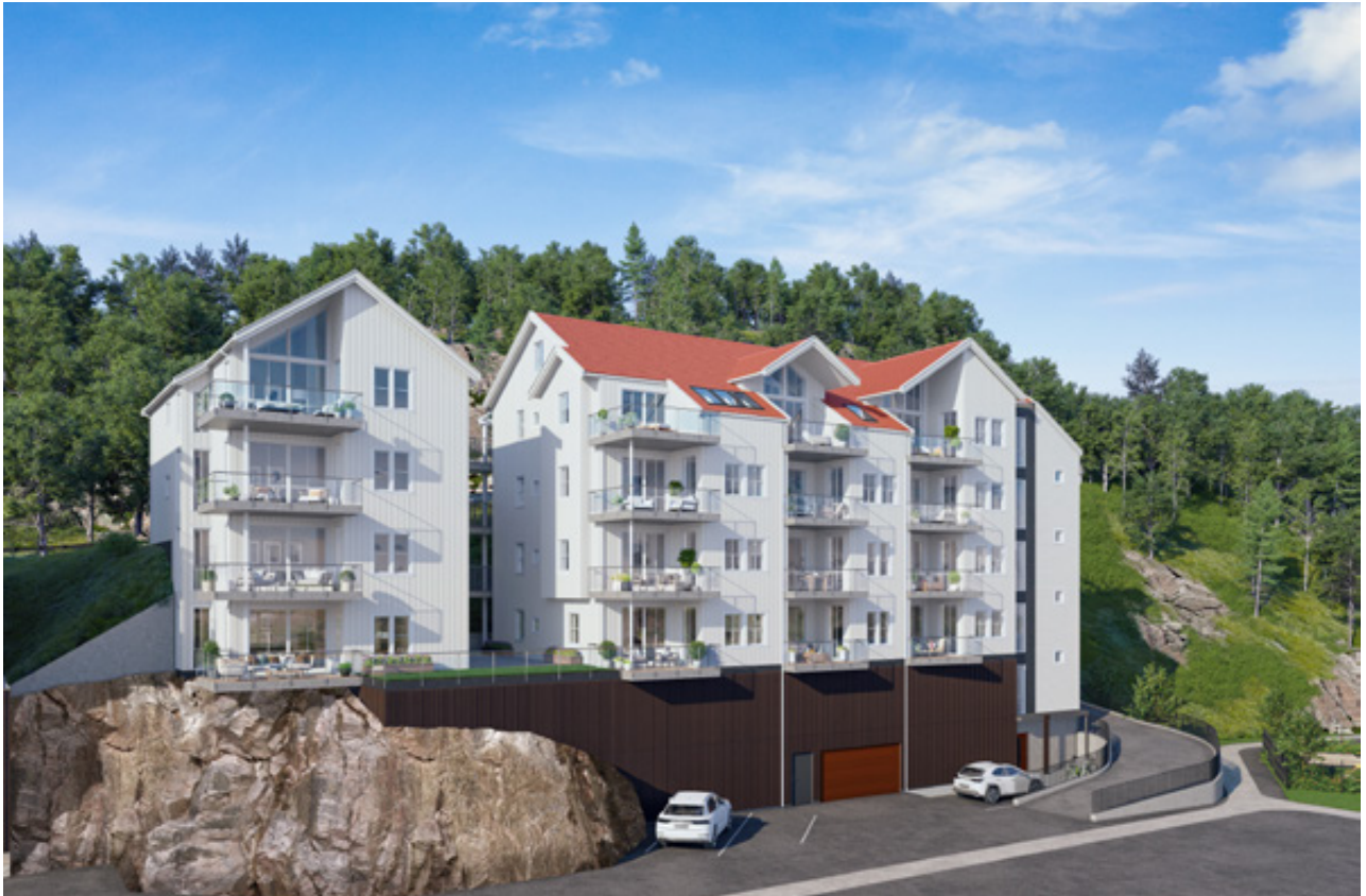
Det er garasje i 1. og 2. etasje
